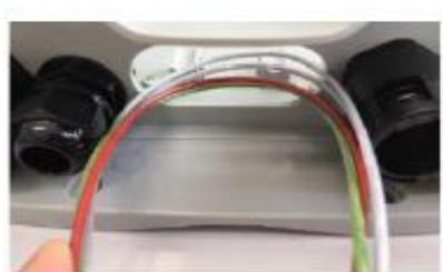
Spingere entrambe le teste del cavo all'interno del PTE fino alla staffa di fissaggio presente subito all'interno del vano, inserendo l'anima centrale attraverso l'accessorio di fissaggio e lasciando liberi i tubetti.
