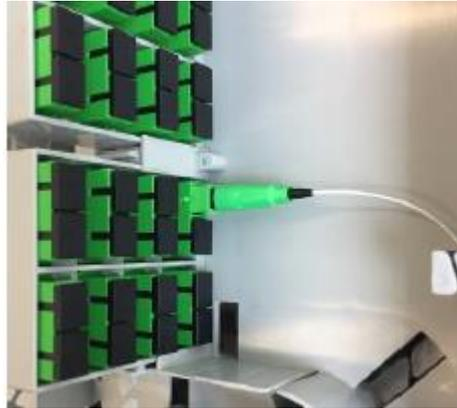
Disperdere l'extralunghezza di fibra del cavetto nella parte frontale del modulo basculante come mostrato in figura
