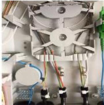
Parcheggiare 24 fibre per modulo nei moduli di giunzione partendo dal modulo in basso.
