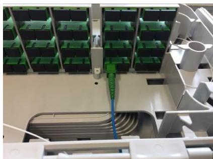
Una volta terminato il cablaggio, fissare la bretella sul pettine come indicato in figura.
