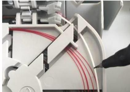
Giuntare la semibretella alla fibra del cavo di rete, posizionare il giunto nell'alloggiamento e disperdere la ricchezza di fibra all'interno del modulo.
