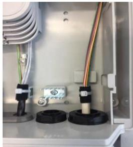
Instradare le fibre sul modulo basculante attraverso il percorso indicato in figura.
