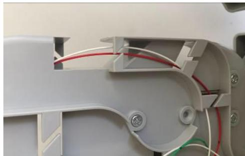
Assemblare sulla/sulle fibre da terminare un connettore SC/APC montabile in campo Terminare la fibra sul manicotto SC/APC sulla rastrelliera di terminazione lato destro con un criterio di riempimento che va da destra verso sinistra e dal basso verso l'alto.
