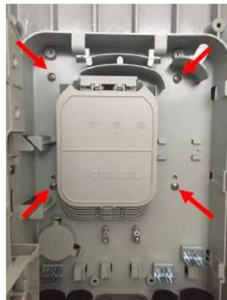
Nel caso di installazione ad uso ibrido della terminazione ottica ( PTE + Terminazione in rame ) il PTE (Optical Core) deve essere posizionato nella parte alta della colonnina tramite una staffa da fissare con asola rivolta verso l'alto con 2 viti M5 in dotazione nel kit.
