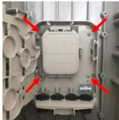
Nel caso di installazione ad uso ibrido della terminazione ottica (PTE + Terminazione in rame) il PTE deve essere posizionato nella parte alta della colonnina tramite una staffa da fissare con asola rivolta verso l'alto con 2 viti M5 in dotazione nel kit.
