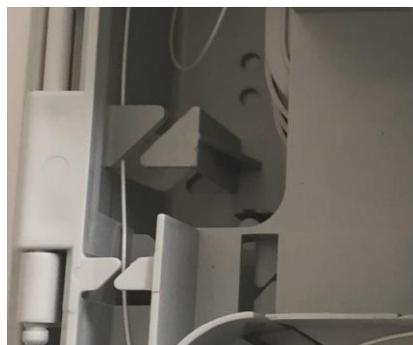
Assemblare sulla fibra da terminare un connettore SC/APC montabile in campo e terminare la fibra sul manicotto SC/APC sulla rastrelliera di terminazione lato destro con un criterio di riempimento che va da destra verso sinistra e dal basso verso l'alto.
