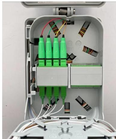
Disperdere l'extralunghezza delle fibre nella parte posteriore del modulo basculante come mostrato in figura
