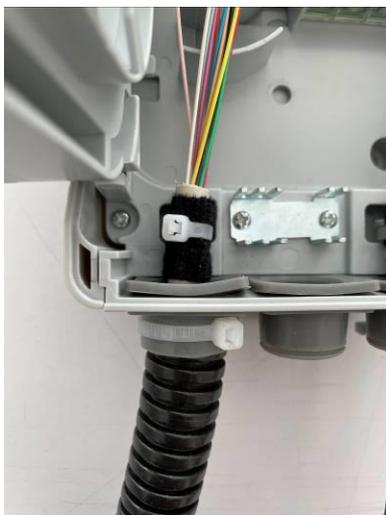
Selezionare la/le fibre da terminare e parcheggiare le fibre non utilizzate nella zona predisposta sul modulo basculante
