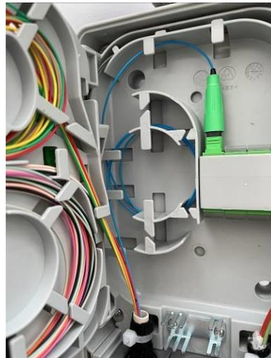
Nel caso di inserimento diretto della bretella, incidere il cono interno della guarnizione n.2 nel centro del modulo (ingresso dedicato alle bretelle di collegamento OAO e/o cavetti singoli TIM) con delle forbici
