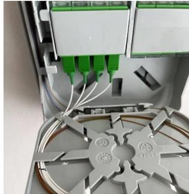
Giuntare le semibretelle alle fibre del cavo di rete, posizionare i giunti nell'holder e disperdere la ricchezza di fibra all'interno del modulo
