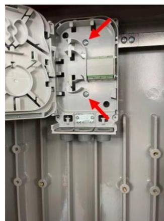
L'Optical Core all'interno della colonnina deve essere fissato con 2 viti M5 in corrispondenza dei fori filettati sulla staffa (in alto).
