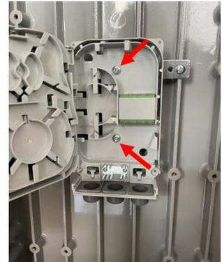
Nel caso di installazione ad uso ibrido della terminazione ottica (PTE + Terminazione in rame) il PTE (Optical Core) deve essere posizionato nella parte alta della colonnina tramite la staffa di adattamento opportunamente assemblata, da fissare in l'alto.
