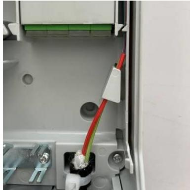
Instradare le fibre nel canale perimetrale del modulo, ed inserirle attraverso l'apposita apertura passandole sulla parte superiore del modulo basculante
