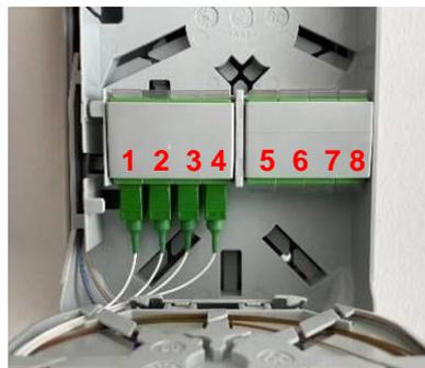
Portare le fibre all'interno del modulo di giunzione dal lato sinistro, segnarle con un pennarello e rimuovere i tubetti di protezione da 900µm
