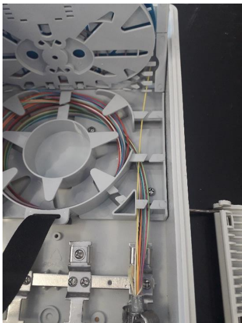
19. Οδηγήστε τους χαλαρούς σωληνίσκους στη βάση των οργανωτήρων συνένωσης
