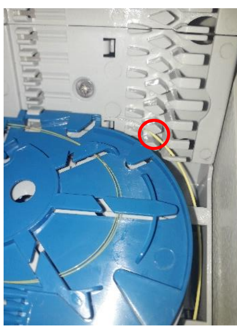
20. Αφαιρέστε τον χαλαρό σωληνίσκο 900μm και οδηγήστε τις ίνες στους οργανωτήρες συνένωσης.
