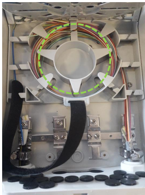
18. Αποθηκεύστε τις ίνες που δεν θα χρησιμοποιήσετε στο κεντρικό κυκλικό τμήμα.
