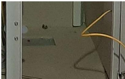
Il passaggio dei cavi avviene semplicemente creando una piccola fessura nella membrana e spingendo il cavo all'interno dell'armadio. Il passacavo così determinato garantisce una protezione IP66.
