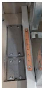
Il passaggio dei cavi avviene semplicemente creando una piccola fessura nella membrana e spingendo il cavo all'interno dell'armadio. Inserito il cavo nella doppia membrana, questa automaticamente sigilla l'apertura intorno al cavo esercitando la necessaria tenuta meccanica. In caso di passaggi non utilizzati si possono sigillare le membrane forate, con inserti ICOTEK tipo ST-B (non previsti nella fornitura).
